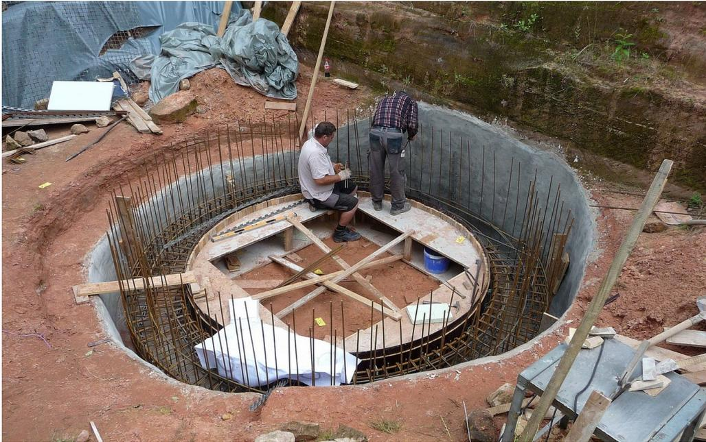
Abb. 5, 6: Herstellen der Stahldrahtarmierung durch Fa. Boesen Bau Kirkel.
