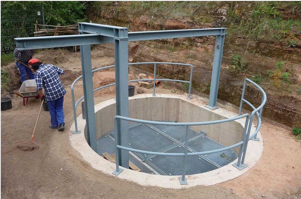
Abb. 8: Der Betonring nach Fertigstellung mit zu öffnendem Gitter und Galgen zum Anschlagen der Fördereinrichtung und persönlichen Absturzsicherung im August 2014. Dieses Bild wird der Brunnen bis zum Ende der Grabungsarbeiten in einigen Jahren bieten.
