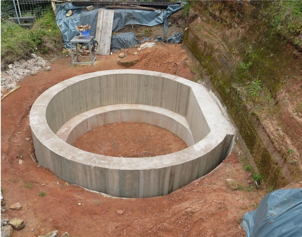
Abb. 7: Der Betonkranz nach dem Ausschalen
