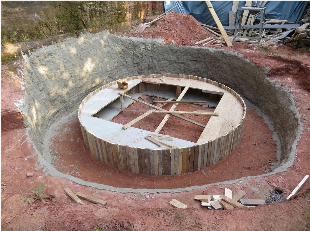
Abb. 4: Aufbringen von Luftkalkmörtel auf die Felsflächen, um einen Kontakt zwischen Sandstein und Beton zu verhindern. Aufbau der Verschalung innen (Fa. Boesen Bau).
