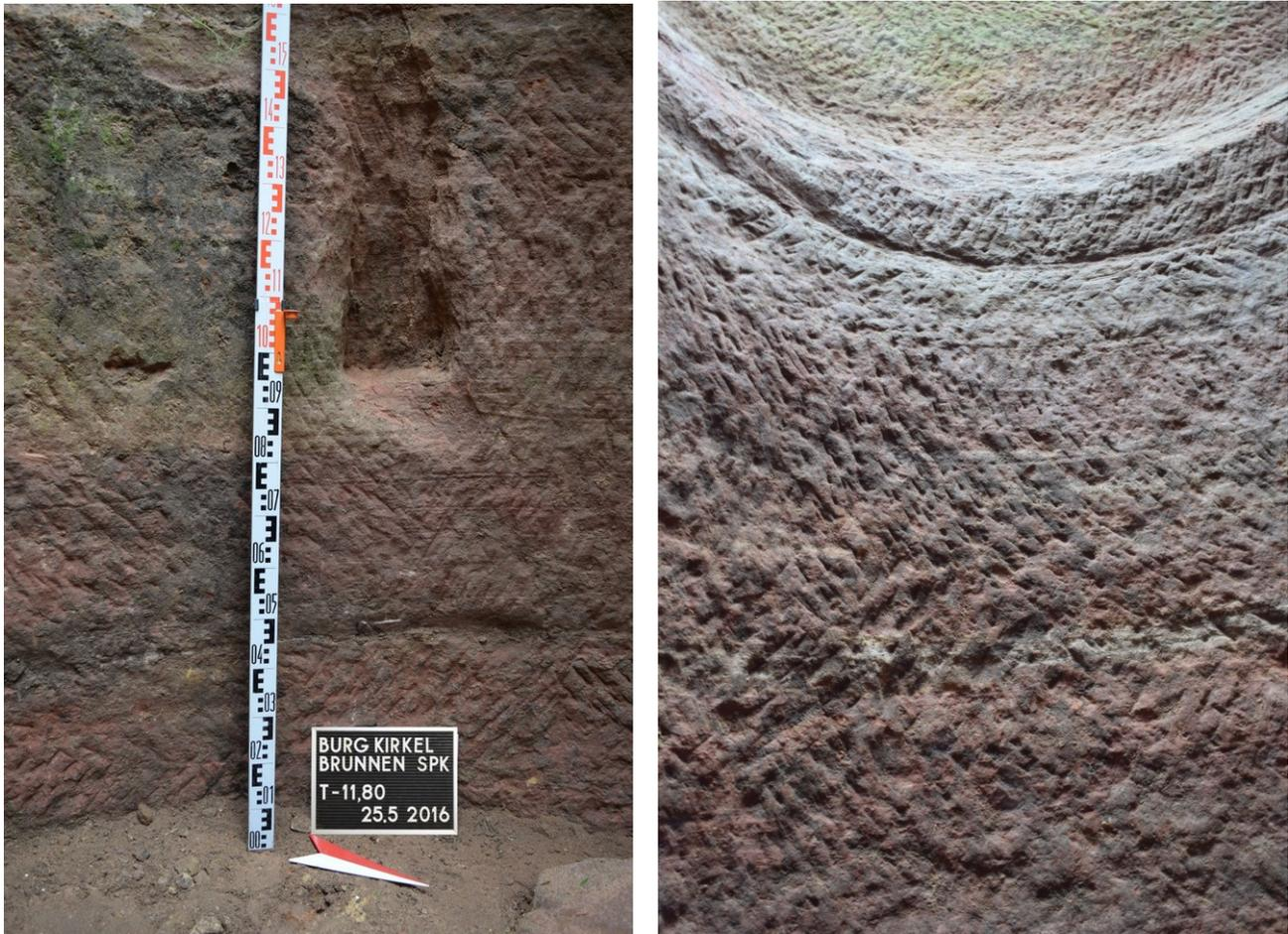
Links: ein Balkenloch und überwiegend längliche Bearbeitungsspuren in 2,80-3,30 m Tiefe unter der Oberfläche. Rechts: mehrheitlich kurze Hiebsspuren in ca. 7 m Tiefe.
