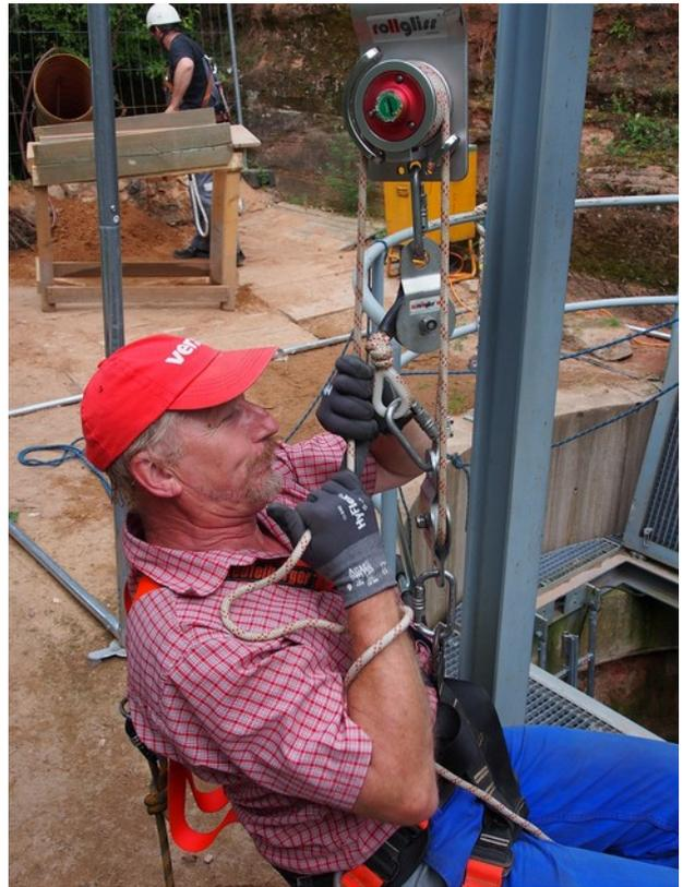
Außerdem dient es zum Sichern von Personen bei Arbeiten in der Höhe oder Tiefe. Darüber hinaus können auch Lasten damit transportiert werden. Die Ausstattung umfasst außer dem Grundgerät ein 60 Meter langes Sicherheitsseil, Karabinerhaken, ein Seilstoppperät mit Bremshilfe (Abb. li.) und einen Universalgurt, der als Auffang-, Einstiegs- und Rettungsgurt verwendet werden kann.
