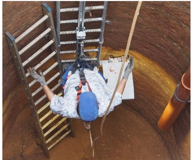
Die Leiter ist mit einer Schiene versehen, in der ein Mitläufer eine Absturzsicherung bietet. Man hakt den Karabiner des Geräts an der PSA ein. Im Ab- oder Aufstieg läuft es frei hängend (Abb. li.). Stürzt die Person, wie Anne Bernimollin demonstriert (Abb. re.), tritt sofort die Bremswirkung in Kraft. Das System wird im Bergbau eingesetzt und je nach der Abbautiefe nach unten in Segmenten von je 6 m verlängert werden. Bis dahin hilft die separate Leiter für den untersten Abstieg.
