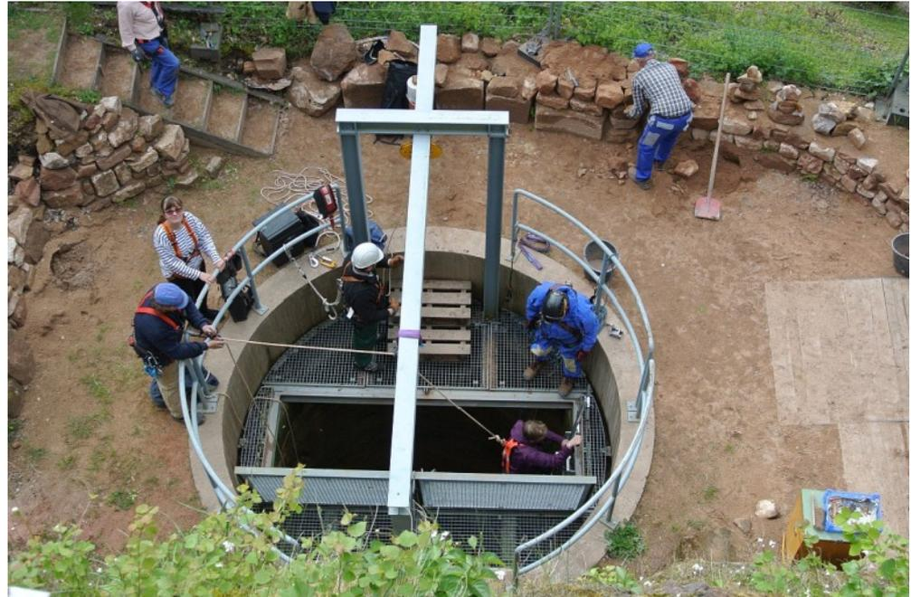
*Abb. 1: Bärbel Fecht fährt in die Brunnenröhre ein. Tom Bronder sichert sie am Rücken mit dem Seil am Gurt der PSA (persönliche Schutzausrüstung).*
