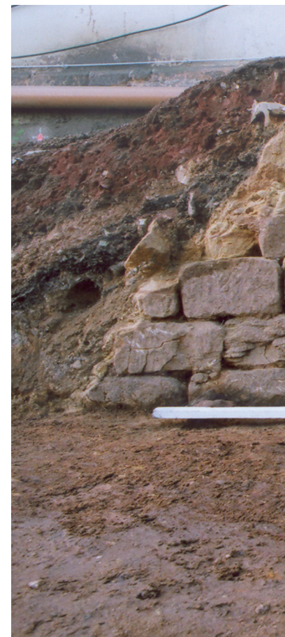
Abb. 5: Der älteste Bauteil der Burg Blieskastel ist eine Beringmauer, die entlang der Nordseite über fast 40 m Länge zu verfolgen ist. Datierung: Vermutlich 11.–12. Jahrhundert. Foto: Christel Bernard, 2006/2007.
