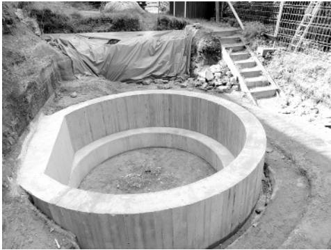
▲ Abb. 3: Bauarbeiten am Brunnen 2014. Der Felsrand wurde bis auf tragfähigen Sandstein abgetragen und ein neuer Kranz betoniert (Foto: Anne Bernimollin).
