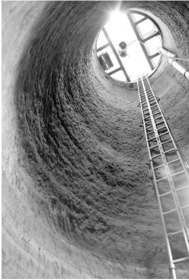
▲ Abb. 6: Die Brunnenröhre ist nahezu zylindrisch aus dem Sandsteinfels herausgearbeitet. Blick von der Sohle der Freilegung aus nach oben (Foto: Christel Bernard).
