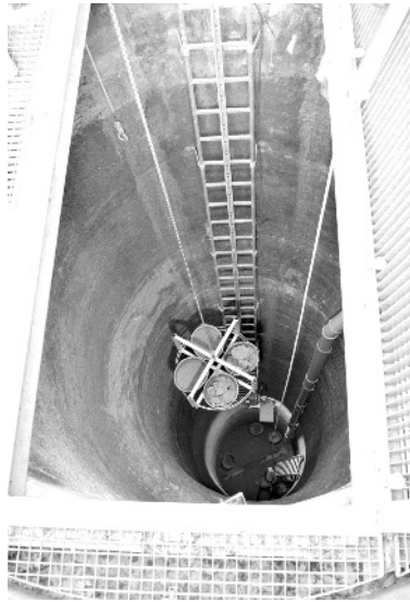
▲ Abb. 5: Freilegung im Brunnen. Eimer mit Schutt werden nach oben befördert, während eine Person in der Tiefe weitere Erdmassen abträgt (Foto: Christel Bernard).
