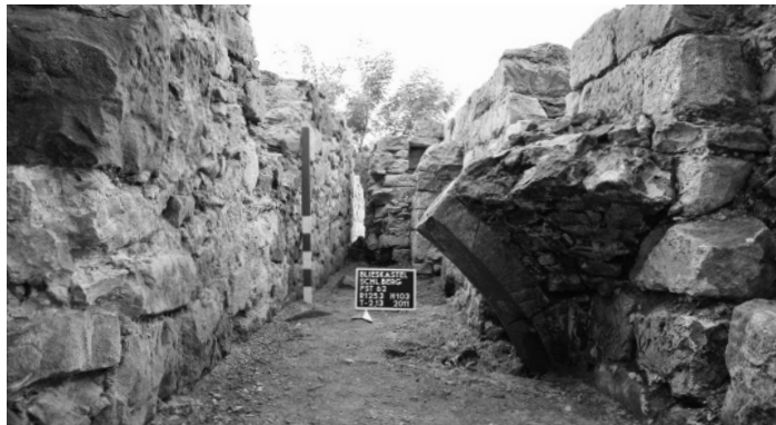
Abb. 7: Rest eines mittelalterlichen Kreuzrippengewölbes. Dieser Raum der Burg wurde für den Bau des barocken Weinkellers zerstört, dessen Ostmauer man links sieht (Foto: Christel Bernard).
