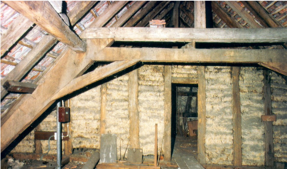
Abb. 27 und 28: Holzständerwand zwischen Wirtschafts- und Wohnteil, die mit Lehmstroh umwickelten Holzstaken (sog. Lehmwindeln) ausgefacht ist, oben vom Wohnteil, unten vom ehem. Wirtschaftsteil aus gesehen. Zur Dachkonstruktion vgl. Abb. 24 (Fotos J. Selmer, 2000).
