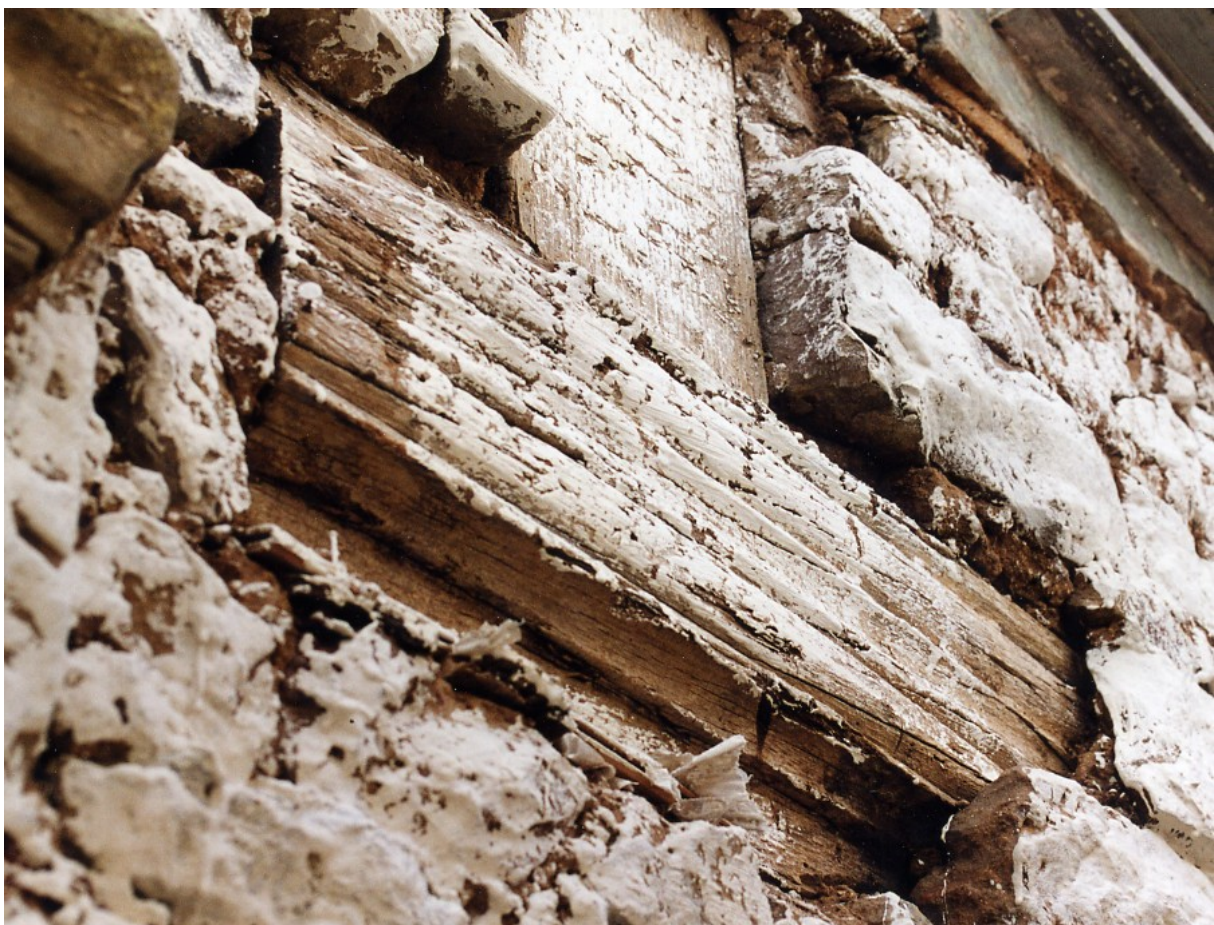
Abb. 23: Das beim Abschlagen des Verputzes freigelegte linke Ende des profilierten Schwellbalkens aus Eichenholz, darauf aufgesetzt ein Ständerbalken des Fachwerks vom Obergeschoss (Foto J. Selmer, 2000).
