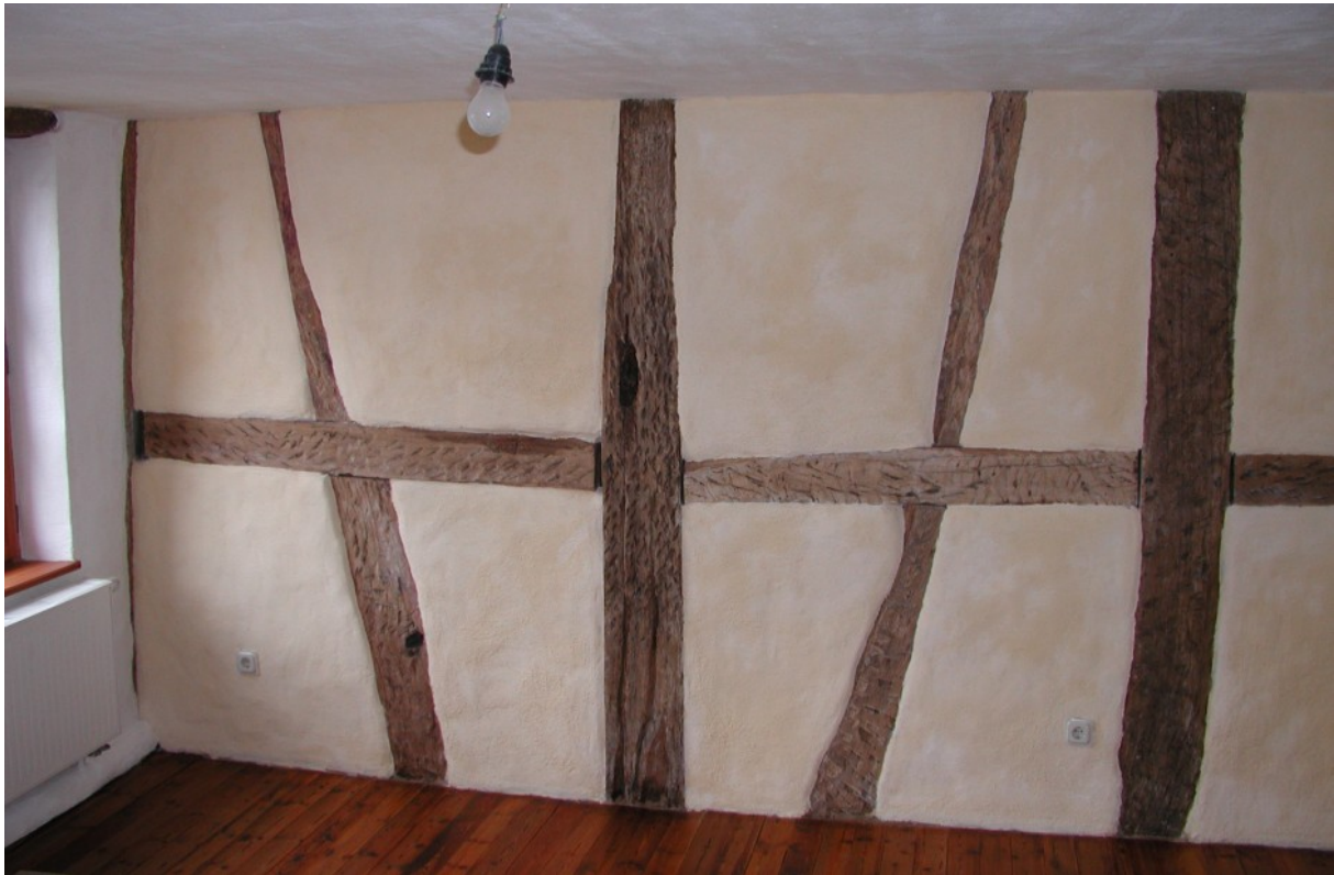
Abb. 29: In Fachwerkbauweise ausgeführte Innenwand nach dem Entfernen überdeckender Putzschichten und der Ausbesserung des größtenteils noch original erhaltenen ersten Verputzes in den Ausfachungen. Die Ausbesserung erfolgte mit zementfreiem Luftkalkmörtel, der Anstrich mit selbst hergestellter Kalkkaseinfarbe. Darüber schließt die Holzständerwand Abb. 27–28 im Dachraum an (Foto J. Selmer, 2003).
