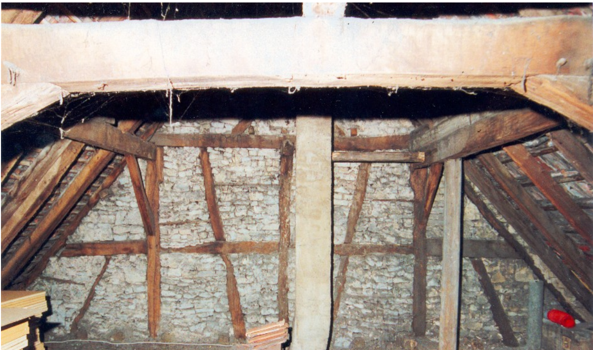
Abb. 26: Unverputzte östliche Giebelwand zu Haus Nr. 93 im ehemaligen Wirtschaftsbereich. Die Balken sind schwächer und es wurde nur ein Riegel verbaut (Foto J. Selmer, 2000).
