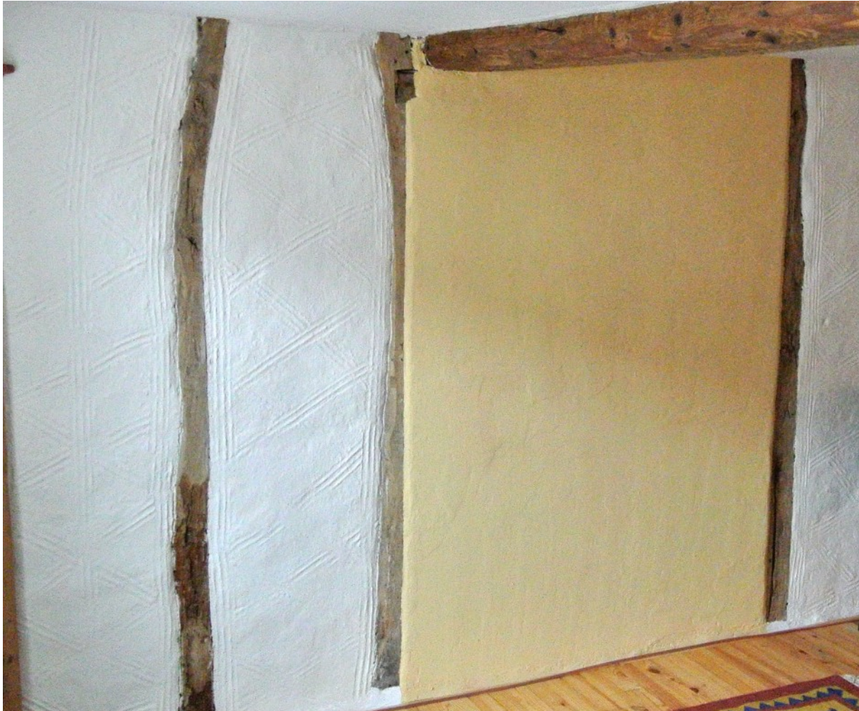
Abb. 16: Ausgestakte Holzständerwand mit Lehm-Stroh-Füllung zwischen Flur und Stube. Der fingerstrichverzierte Lehm ist mit selbstgemachter Kalkkaseinfarbe gestrichen. Im gelb gefassten, vermauerten Abschnitt in der Mitte ist der Sturz eines ehemaligen Durchgangs erkennbar, der als Auflager für einen später hinzugefügten Deckenunterzug aus Kiefernholz dient (Foto. J. Selmer, 2013). Darüber befindet sich die tragende Fachwerkwand Abb. 29.
