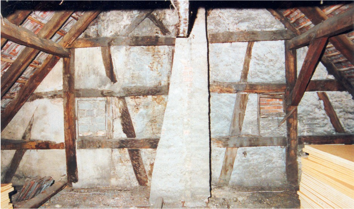
Abb. 25: Der Dachstuhl ist größtenteils noch im originalen bauzeitlichen Zustand des frühen 18. Jhs. erhalten. Hier der Bereich oberhalb des alten Wohnteils mit der innen verputzten westlichen Giebelwand zu Haus Nr. 89. In der Wand befinden sich zwei vermauerte Nischen, die vor dem Anbau des Nachbarhauses als Lichtöffnungen dienten. Versteckt hinter der Vermauerung einer Nische befanden sich zwei sorgfältig in Wachspapier eingewickelte Seitengewehre aus der Zeit des Ersten Weltkriegs. An der Giebelwand links sind die Ansatzspuren des ehemals größeren Rauchfangs erkennbar (Foto J. Selmer, 2000).
