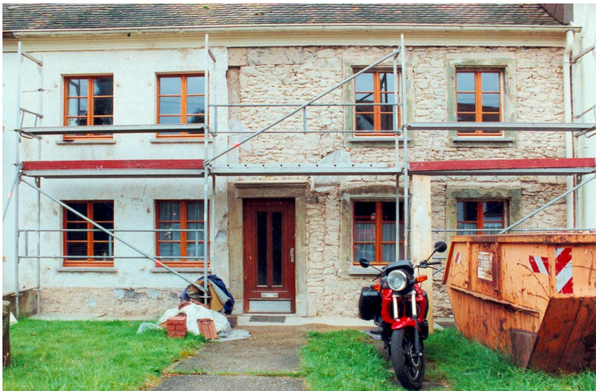
Abb. 22: Ansicht nach dem Abschlagen des Verputzes von der Bruchsteinaufmauerung des ursprünglichen Wohnteils. Die Fassade des ehem. Wirtschaftsteils links war in den 1950er Jahren mit Hohlblocksteinen neu aufgeführt worden. Der zwischen Tür- und Fenstersturz im Erdgeschoss freigelegte Abschnitt des Schwellbalkens von der Fachwerkkonstruktion des Obergeschosses ist hier mit einer Kunststoffolie abgedeckt. Er wird im weiteren Verlauf teilweise von dem später eingebauten Fenstersturz überdeckt. Erkennbar ist auch die teilweise von der Laufebene des Gerüsts verdeckte, bis zum rechten Hausgiebel reichende Verkleidung des Schwellbalkens mit Kalksteinplatten (Foto J. Selmer, 2000).
