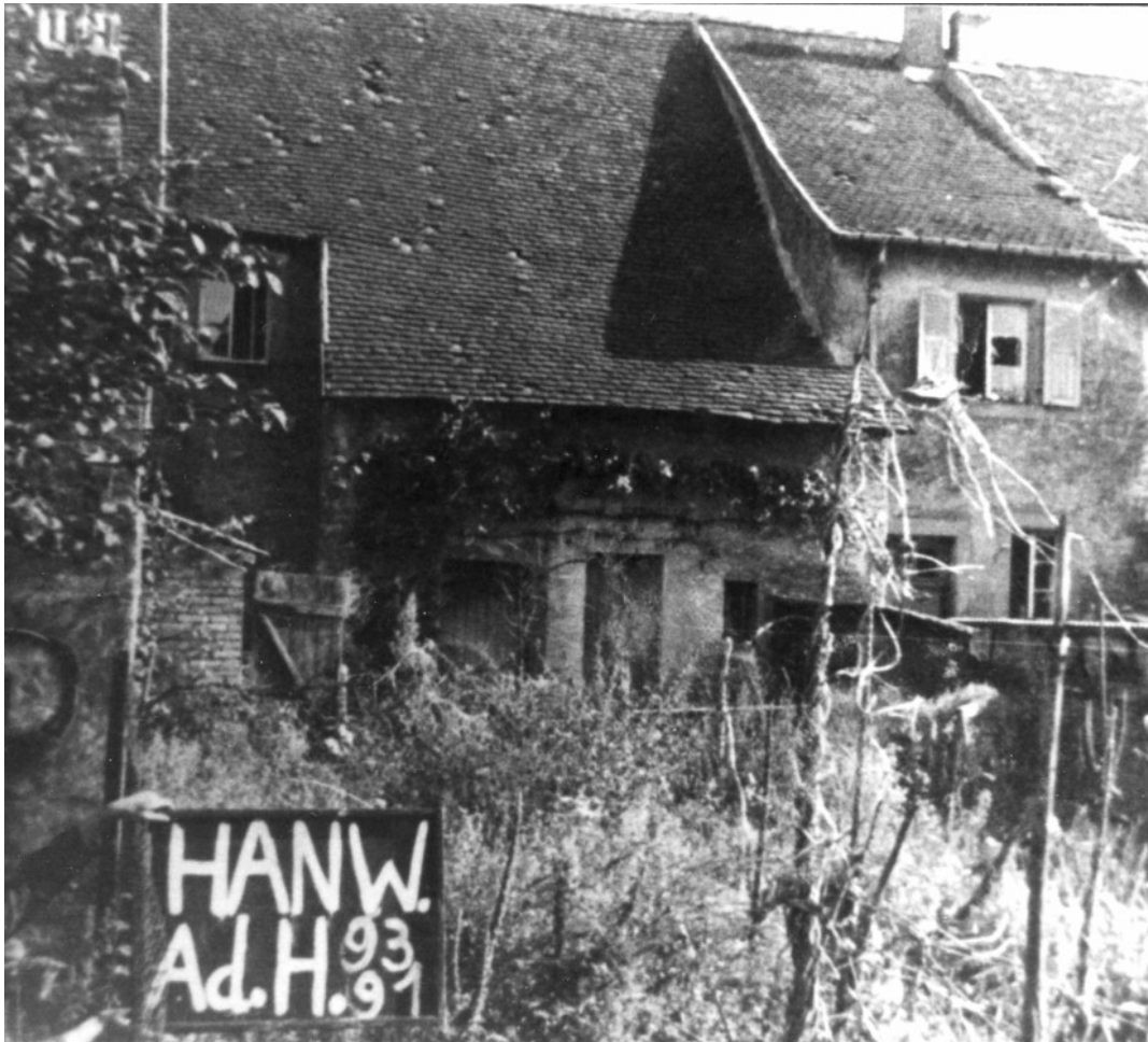
Abb. 30: Vom sog. „Wiederaufbau“ (Organisation Todt) im Jahr 1941 angefertigte Aufnahme der Hausrückseiten von Nr. 91 (links) und 93. 66 Die Häuser befinden sich in einem schlechten Zustand und erscheinen verlassen – Fensterscheiben sind zerbrochen, Türen und Fenster stehen offen, der Garten wird nicht bewirtschaftet – sicher eine Folge der Zwangsevakuierung der grenznahen „Roten Zone“ 1939–1940. Der Wirtschaftsteil ist zu diesem Zeitpunkt noch nicht zu Wohnzwecken umgebaut. In der Mitte die 1954 vermauerte Tür zum Garten. In einem der beiden niedrigen Häuschen befand sich höchstwahrscheinlich der Abtritt. Die Dacheindeckung bestand noch aus Biberschwanzziegeln. Mehrere Ziegel fehlen oder sind beschädigt, möglicherweise durch Beschuss. Weder vorne noch hinten am Haus war eine Regenrinne angebracht.
