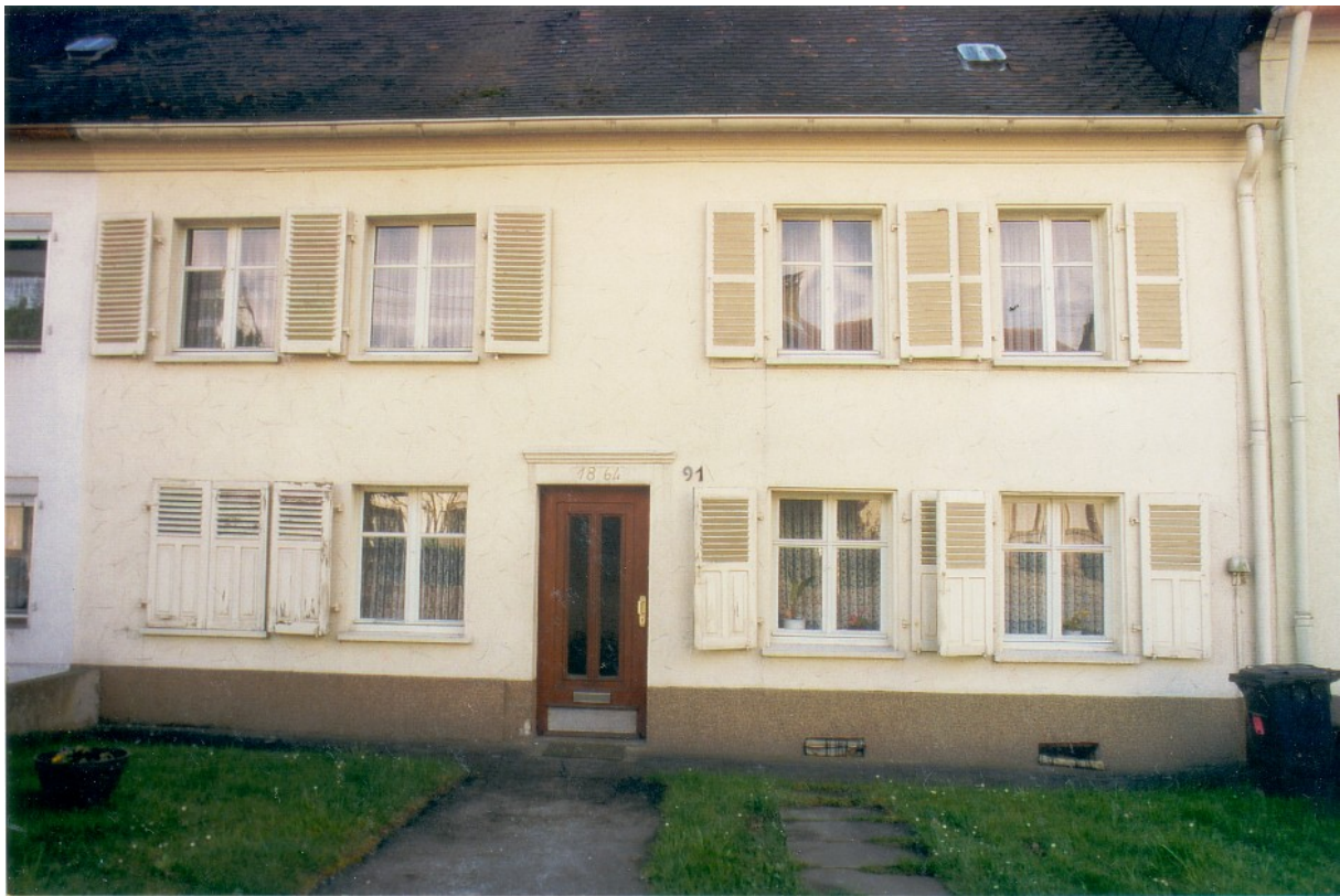
Abb. 7: Das Haus im Zustand von 1999: Sprossenfenster mit Einfachverglasung, Fenster- und Türgewände größtenteils überputzt, das Holz der Fensterläden stellenweise angefault. Die mit zementhaltigem Putz hergestellte und sich z. T. vom Mauerwerk ablösende Sockelzone sowie der stark filmbildende und sich ebenfalls z. T. ablösende Anstrich verursachen eine partielle Durchfeuchtung des Mauerwerks im Erdgeschoss des alten Wohnteils (von vorne gesehen die rechte Haushälfte). Zum Zustand nach der Renovierung der Fassade im Jahr 2001 siehe Abb. 37 am Ende dieses Berichts (Foto J. Selmer).
