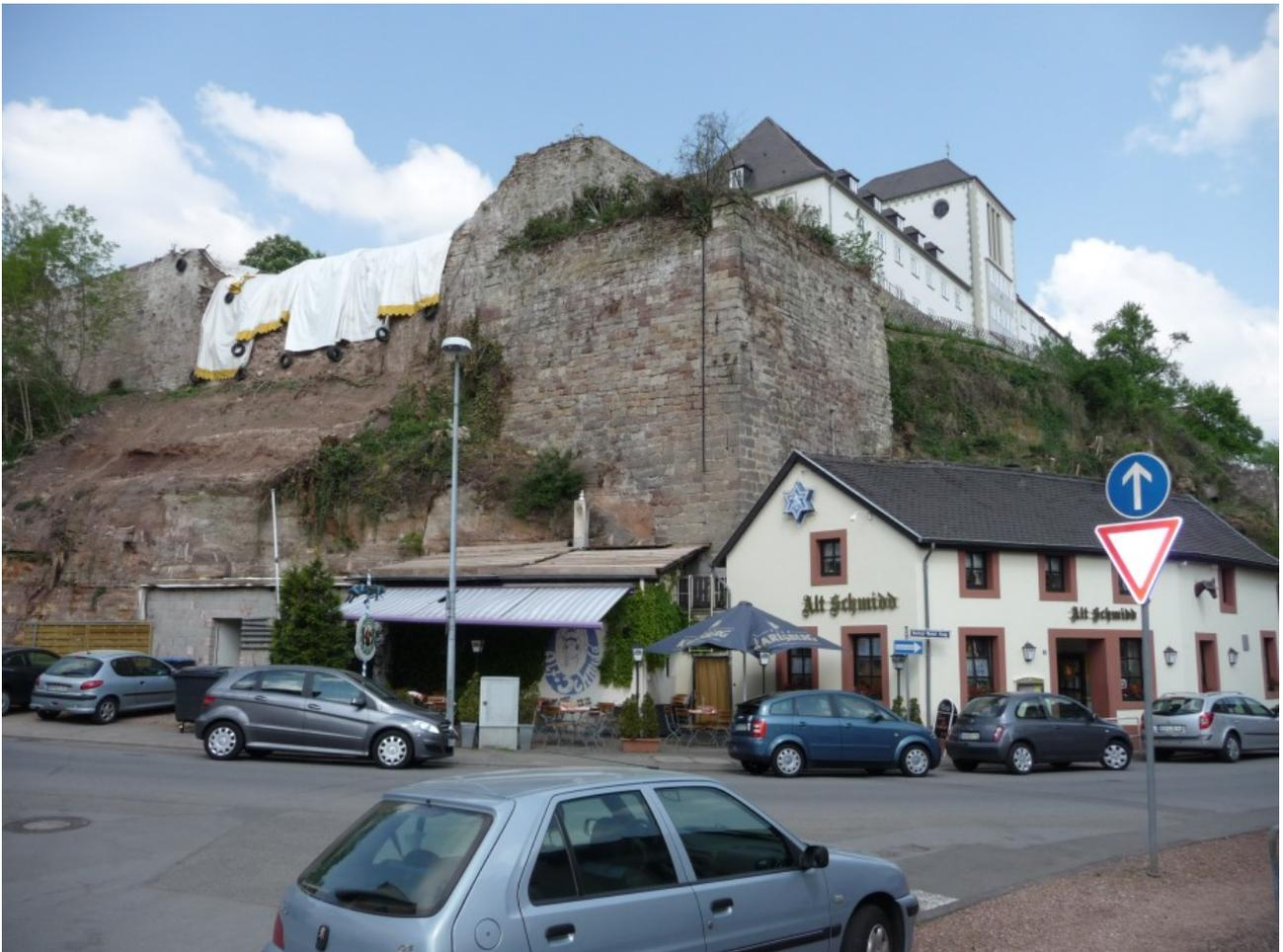
Abb. 16: Nach dem Abgang von Mauerteilen oberhalb der Saargemünderstraße wurde lose Bausubstanz abgetragen und die Vegetation entfernt. Zustand im April 2011 (Foto C. Bernard).
