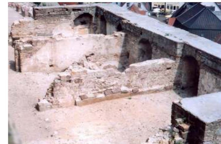
Der Mittelrisalit im Corps de Logis
