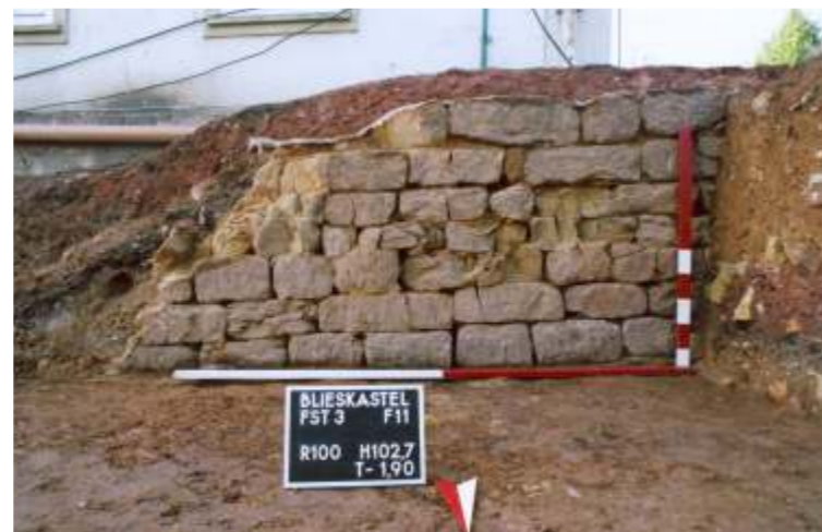
Die mittelalterliche Ringmauer
