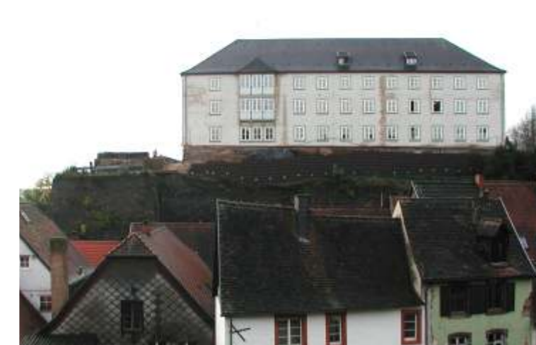
Die Nordmauer ist gesichert.
