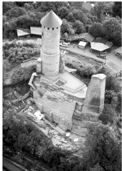
Abb. 3: Burg Kirkel 2002. Türme und Oberburg sowie die östliche Felsflanke sind gesichert, das alte Treppenhaus zur Oberburg ist mithilfe einer Stahltreppe ergänzt. (Foto M. Scheller)
