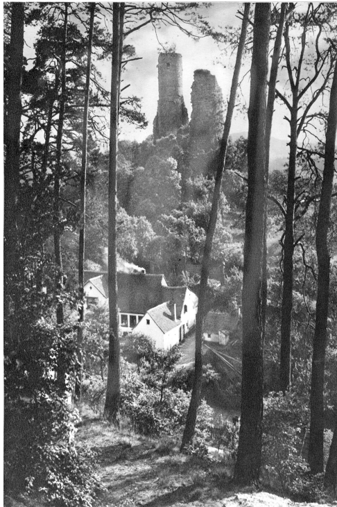
Abb. 2: Zu Beginn des 20. Jahrhunderts waren mit Ausnahme der beiden Turmstümpfe alle Gebäude unter Schutt und Vegetation verschwunden. (Fotograf unbekannt)
