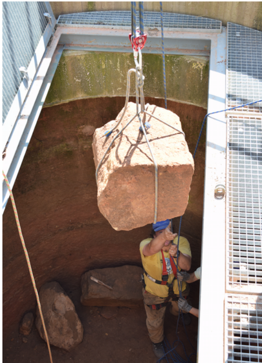
Abb. 2, 3: Schwere Steine werden mit dem Flasenzug gefördert und mit der Laufkatze auf die Fläche neben den Brunnenrand gebracht.
