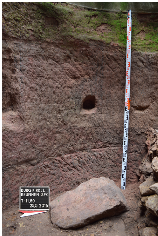
Abb. 1: Hiebspuren vom Aushauen der Brunnenröhre, Balkenlager der ersten Arbeitsbühne.
