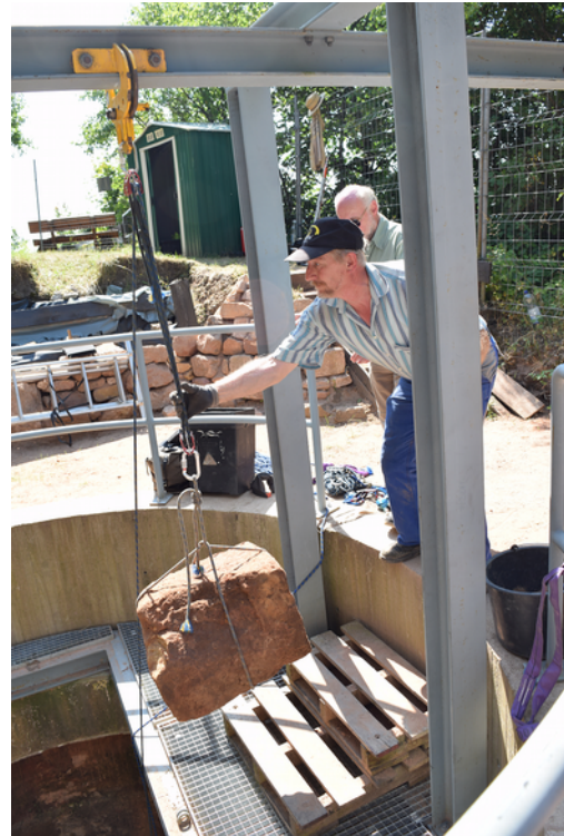
Abb. 2, 3: Schwere Steine werden mit dem Flasenzug gefördert und mit der Laufkatze auf die Fläche neben den Brunnenrand gebracht.
