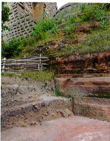
Den nördliche Teil der Grabung. Oberhalb von Profil Nr. 43 erkennt man in der Felswand eine schräge Ausarbeitung für einen Balken, vielleicht einen Sparren des Brunnenhausdaches. Im Vordergrund rechts der stark trichterförmig erodierte Rand des Brunnens. Foto: C. Bernard, 2012
