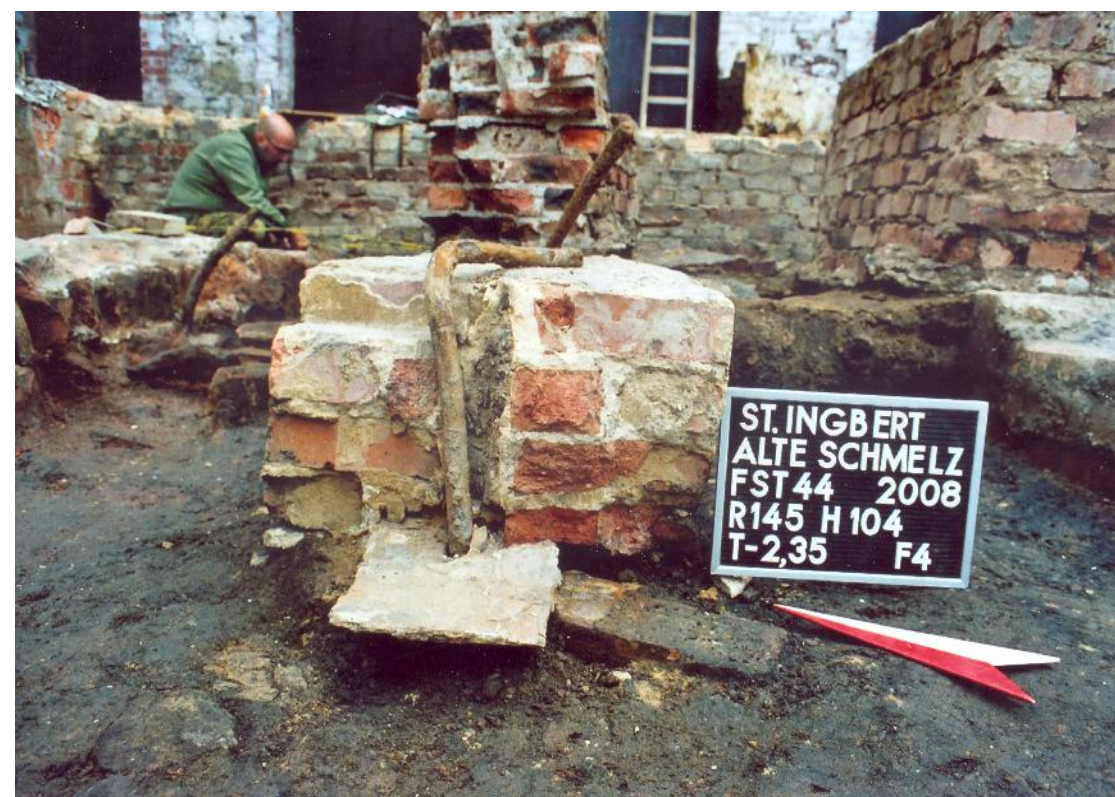
Maschinenfundament aus der frühen Phase der Walzendreherei, Ende 19. Jh.
