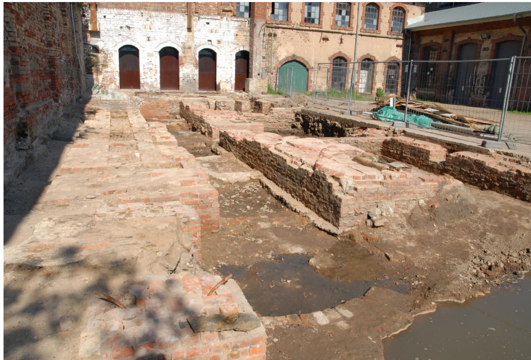
Die Walzendreherei bestand vom Ende des 19. bis zur Mitte des 20. Jhs. Ihr Inneres wurde mehrmals umgebaut. Unter der rezenten Betonfläche traten die beim Abbruch verbliebenen Sockelfundamente der Maschinen zutage.
